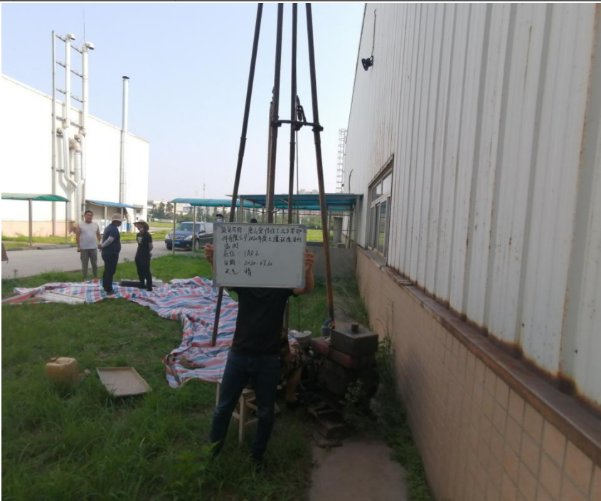
图 4-2-2 现场工作区布置情况
